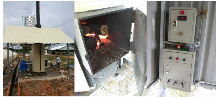
▲雨季の日照が不安定な時期にもワニに適した水温を一定に保つためボイラーを導入。徹底した温度管理を行っています。
