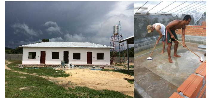
▲現地スタッフが住み込みで24時間管理しています。
