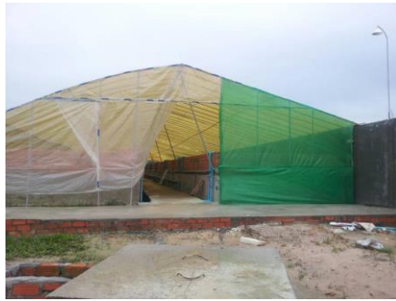
▲雨風から水温の変化を守る設備。
